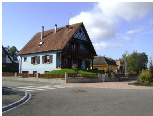
Les caves et remblais sont nombreux et changent la perception des hauteurs (rue de Hilsenheim)
