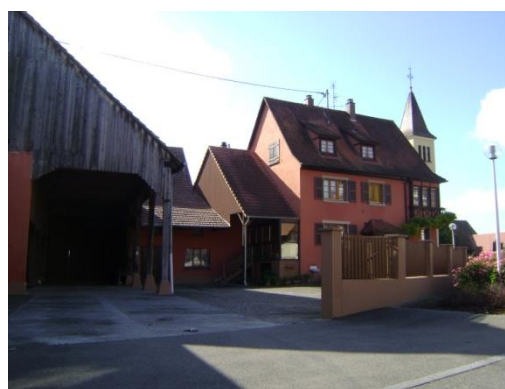
Construction rénovée (rue Principale)
